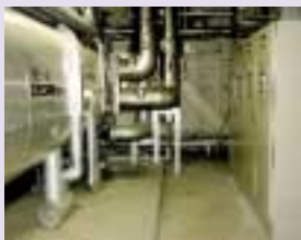
導入された省電力システム
