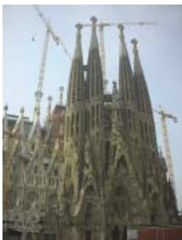
現在の工事の状況
